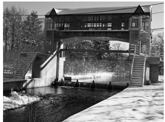
図8. B川に設けられた農業用水取水堰。2008年12月23日。
